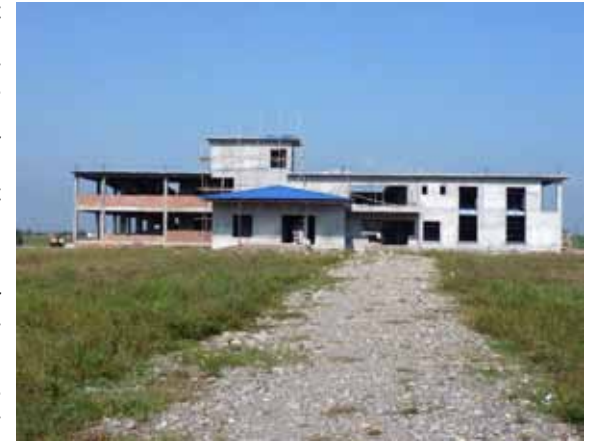
Rohbau des neuen Spitals
